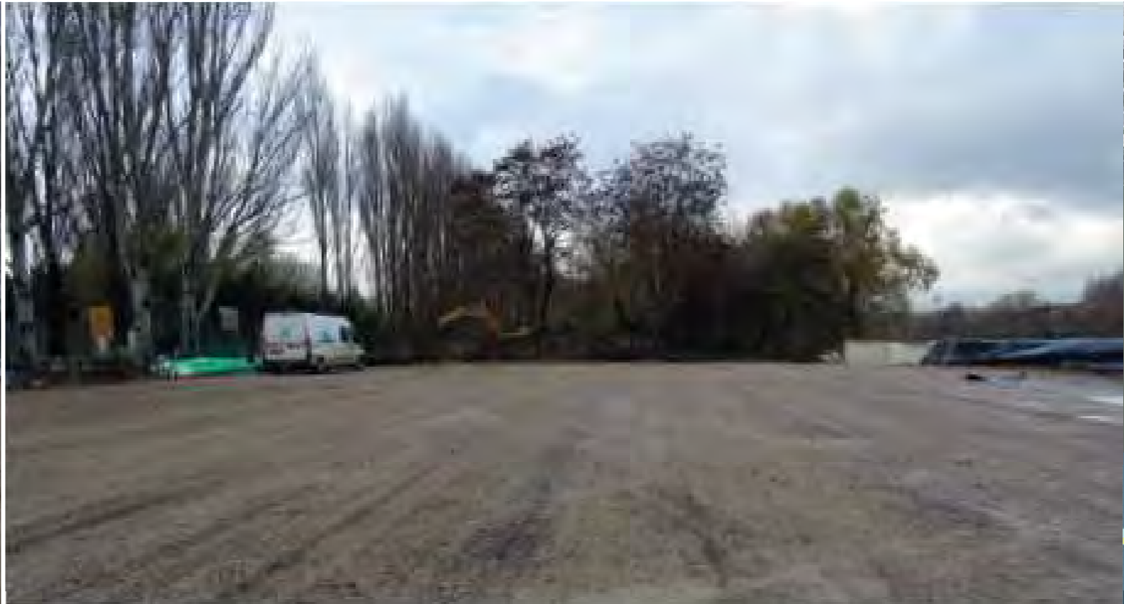
QUAI A USAGE PARTAGE - VUE AVAL
