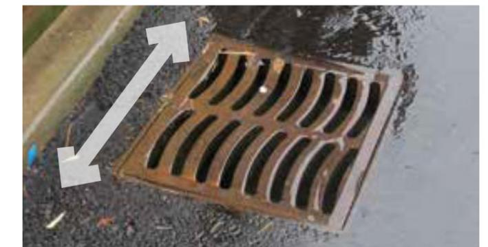
Grille d'égout avec des fentes inférieurs à 2 cm et éloignée d'au moins 10 cm par rapport à un point dur afin de permettre le passage (flèche blanche) de la faune et d'éviter les chutes.
