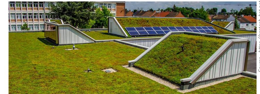
Toiture végétalisée associée à des panneaux photovoltaïques
