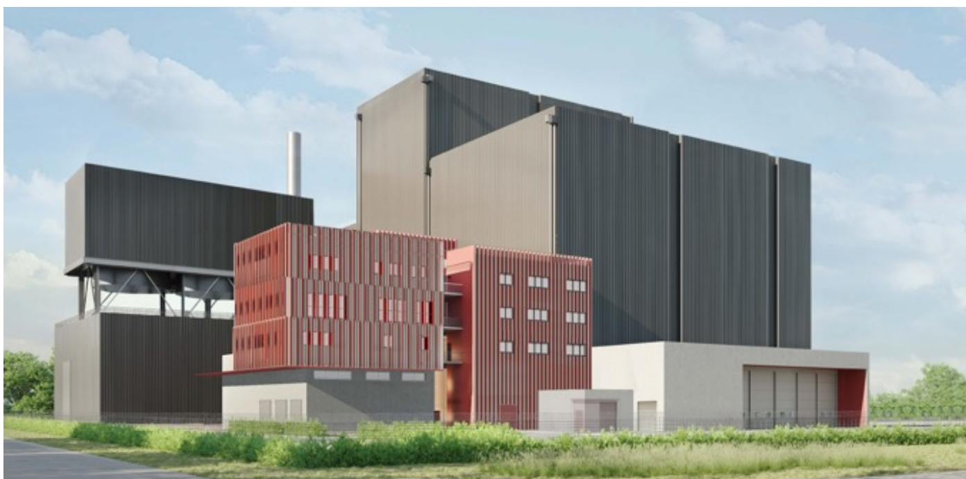
Figure 16 : Visuel de la centrale énergétique
