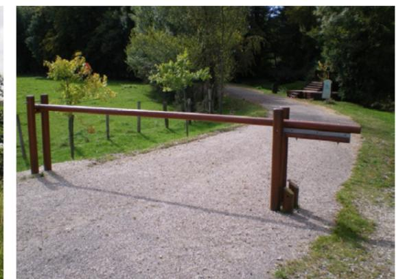
Type de barrière basculante à mettre en oeuvre
