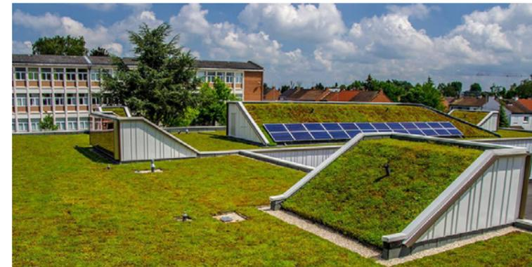
Toiture végétalisée associée à des panneaux photovoltaïques
