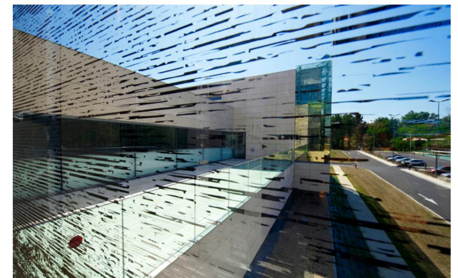
Exemple de système à mettre en place pour éviter les collisions d'oiseaux
