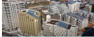
Les lettres (Sogaris), reconversion d'un site indus. de 1,8 ha en quartier mixte (logements, commerces, hôtels et résidence étudiante, ...) - 6 500 m 2 d'espace urbain de distribution
